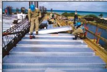
Système de plancher composite ComSlab®
